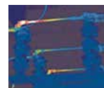
Oxidación de los conmutadores
