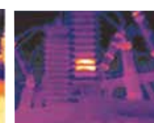
Defectos en aislantes
