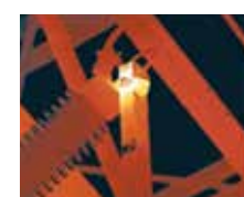
Conexiones mal fijadas
