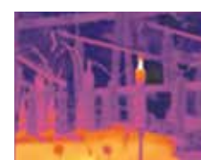
Conexiones sobrecalentadas
